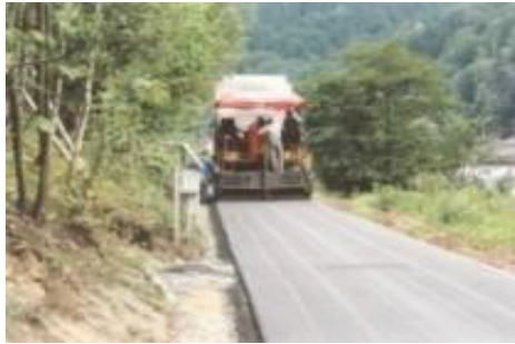
Fertigstellung eines weiteren Abschnittes des Elberadweges 40
