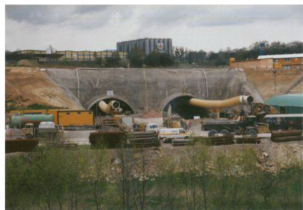
Tunnelbaumaßnahmen der A 17/D8 bei Coschütz 2001 78
