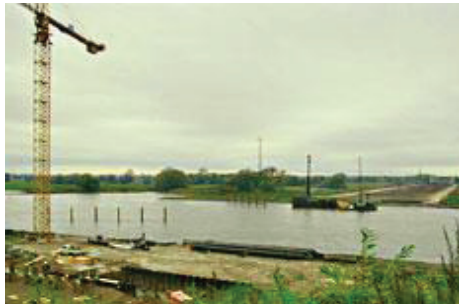
Staufufenbau bei Děčín 97
