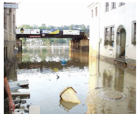
Hochwasser Aug. 2002 Pirna, Dohnaische Str. 74
